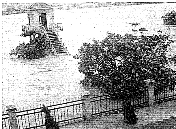
Hình 3. Trạm Thủy văn Kim Long khi mức nước lũ lên 4,28m
