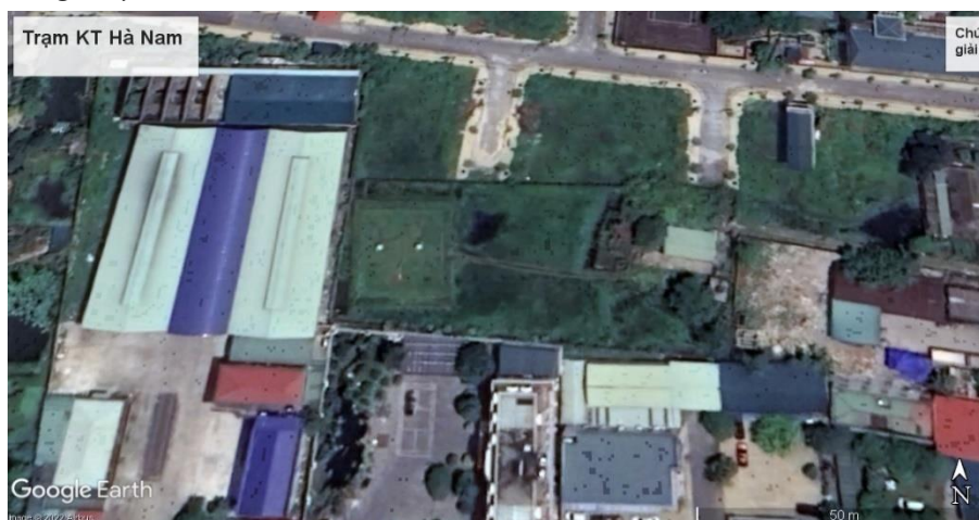
Hình 8. Ảnh chụp hiện trạng khu vực xung quanh vườn quan trắc khí tượng của trạm Hà Nam tại thời điểm tháng 12 năm 2022.
