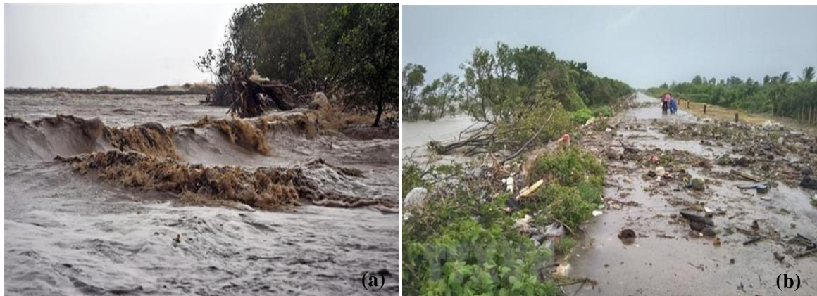
Hình 2. (a) Triều cường dâng cao khiến nước tràn qua mặt đê biển Tây thuộc khu vực xã Khánh Bình Tây, huyện Trần Văn Thời vào chiều ngày 03/8/2019 [21]; (b) Triều cường dâng cao khiến nước tràn qua mặt đê biển Tây thuộc khu vực xã Khánh Bình Tây, huyện Trần Văn Thời vào chiều ngày 11/7/2022 [22].
