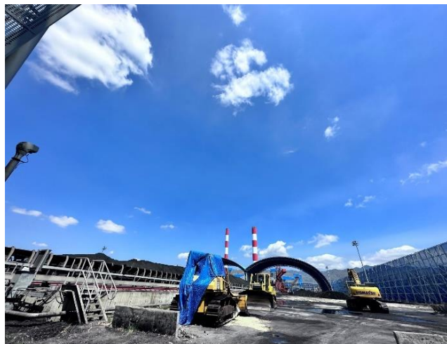
Hình 2. Khu vực kho than hở tại nhà máy.
