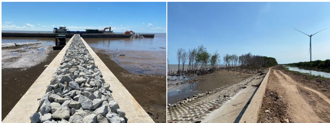
Hình 9. Hình ảnh kè giám sóng đã xây dựng ở KVNC.
